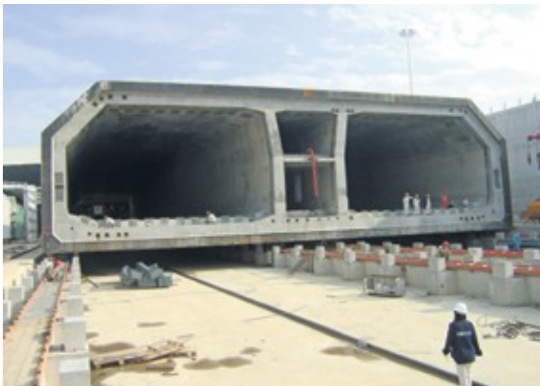
Tunneldeel van 180 meter die afgezonken wordt naar de zeebodem.
